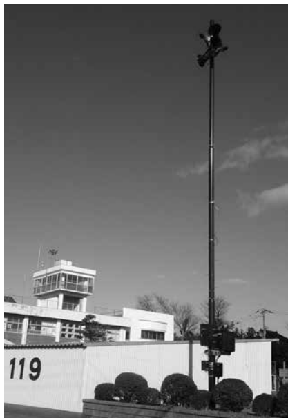
屋外拡声子局施工事例
